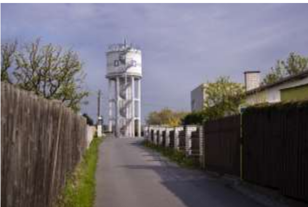
rozhledna na vodojemu v Heřmanově Huti
